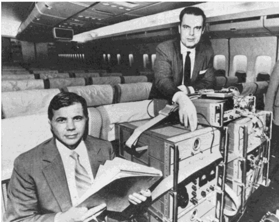
Figure 1 : Joseph C. Hafele (1933-2014) et Richard E. Keating (1941-2006) avec « Mr. Clock » (quatre horloges atomiques qui occupaient deux sièges) Source : Time Magazine, 18 octobre 1971.
